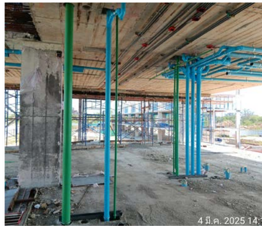
รูปดำเนินการติดตั้งท่อระบบท่อน้ำดี ชั้น 2
