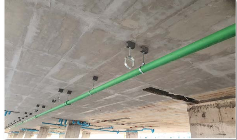
รูปดำเนินการติดตั้งท่อระบบเมนน้ำดี ชั้น 1
