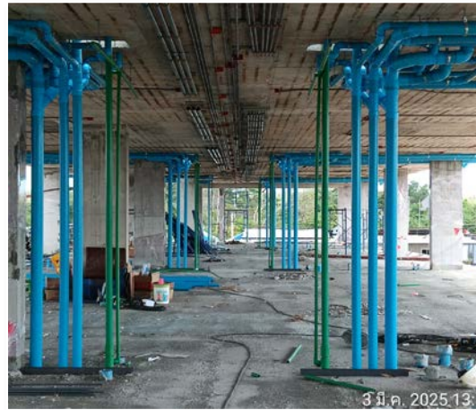
รูปดำเนินการติดตั้งท่อระบบน้ำดี ชั้น 2
