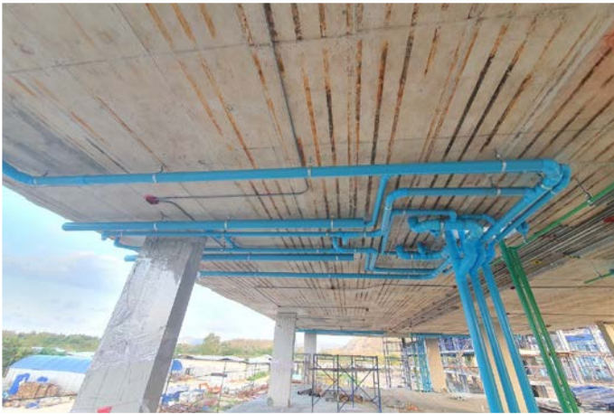
รูปดำเนินการติดตั้งท่อระบบน้ำเสียใต้พื้น ชั้น 3
