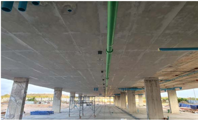
รูปดำเนินการติดตั้งท่อระบบเมนน้ำดี ชั้น 1
