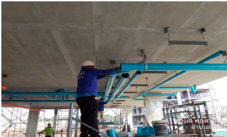
รูปดำเนินการติดตั้งท่อระบบน้ำเสียใต้พื้น ชั้น 2
