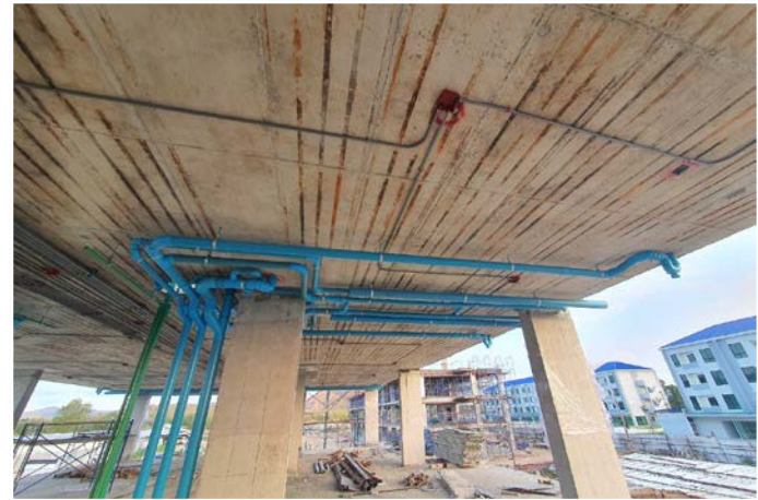
รูปดำเนินการติดตั้งท่อระบบน้ำเสียใต้พื้น ชั้น 3
