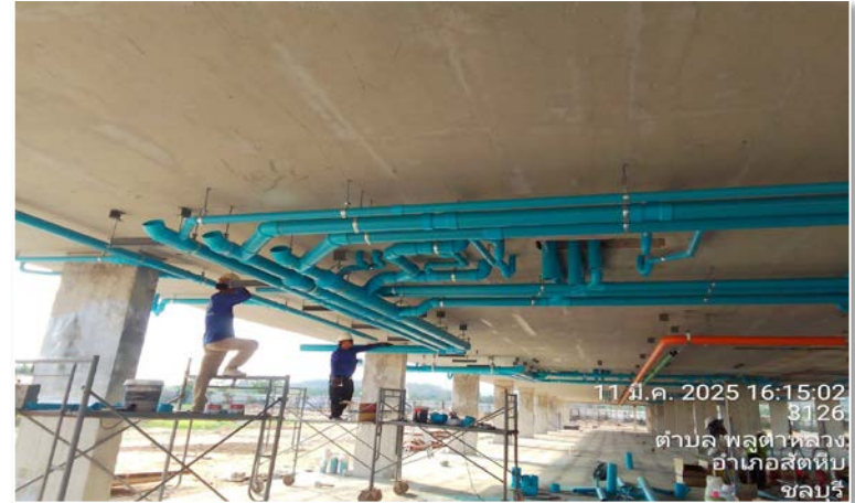
รูปดำเนินการติดตั้งท่อระบบน้ำเสียใต้พื้น ชั้น 2
