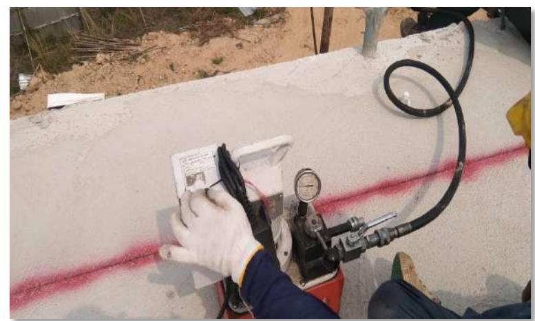
รูปดำเนินการติดตั้งลวดอัดแรงระบบพื้น Post Tension ชั้น 4
