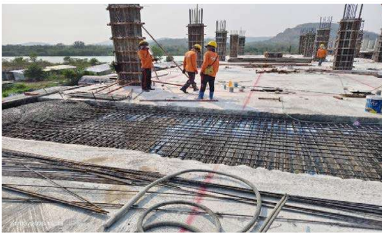
รูปดำเนินการเทคอนกรีตพื้นส่วน Pour Strip ชั้น 4
