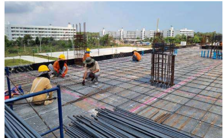
รูปดำเนินการวางเหล็กเสริมพื้นโครงสร้าง ชั้น 4
