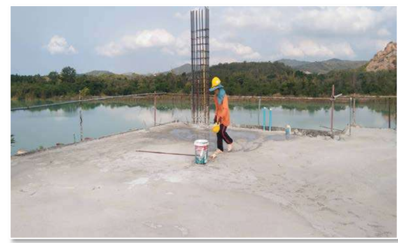
รูปดำเนินการทาสียาบ่มคอนกรีตพื้นโครงสร้าง ชั้น 4
