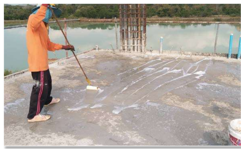
รูปดำเนินการทาสียาบ่มคอนกรีตพื้นโครงสร้าง ชั้น 4
