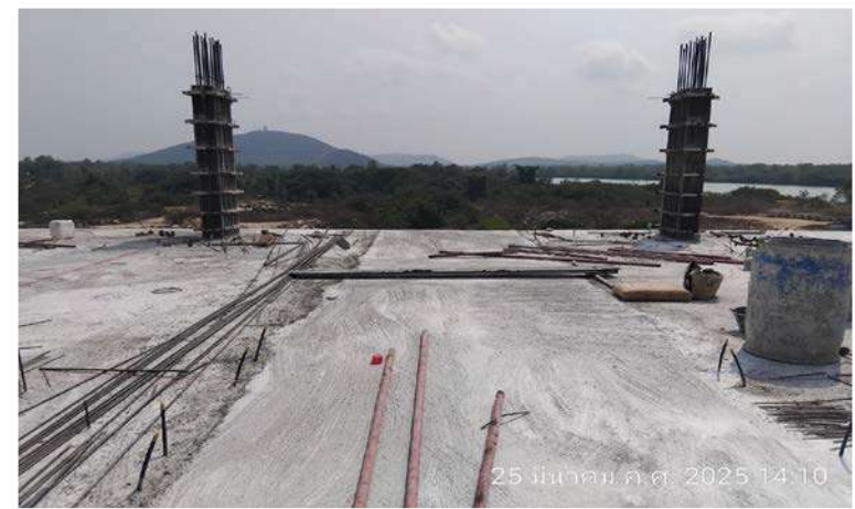
รูปดำเนินการเทคอนกรีตพื้นส่วน Pour Strip ชั้น 4
