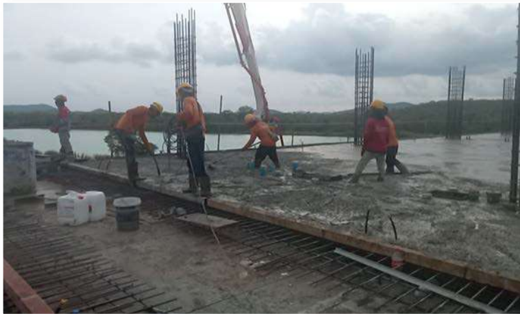
รูปดำเนินการเทคอนกรีตพื้นโครงสร้าง ชั้น 4
