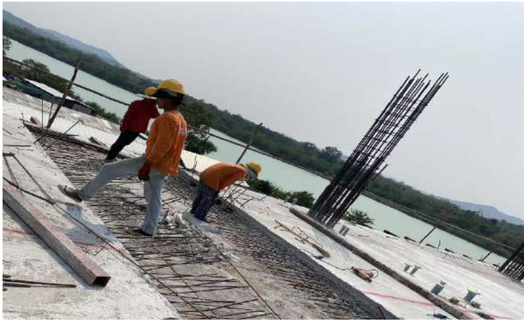
รูปดำเนินการติดตั้งลวดอัดแรงระบบพื้น Post Tension ชั้น 4
