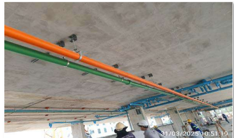
รูปดำเนินการติดตั้งท่อระบบสุขาภิบาล ชั้น 1
