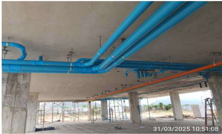
รูปดำเนินการติดตั้งท่อระบบสุขาภิบาล ชั้น 1
