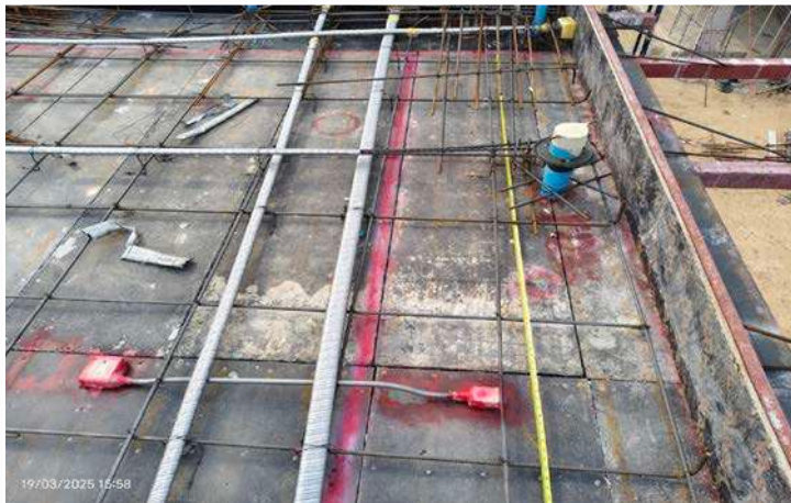
รูปดำเนินการติดตั้งท่อระบบแสงสว่างชั้น 3(ฝังพื้นโครงสร้าง ชั้น 4)
