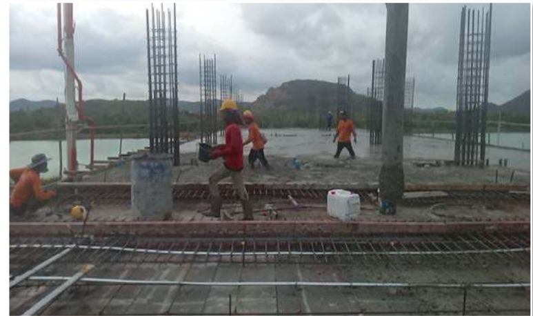
รูปดำเนินการเทคอนกรีตพื้นโครงสร้าง ชั้น 4
