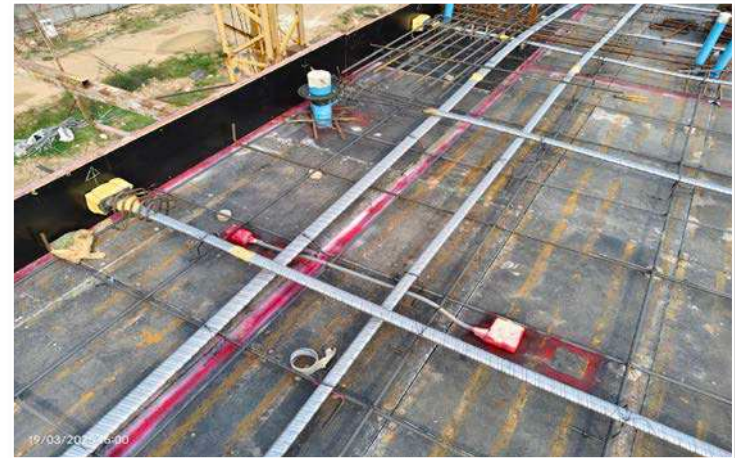
รูปดำเนินการติดตั้งท่อระบบแสงสว่างชั้น 3(ฝังพื้นโครงสร้าง ชั้น 4)
