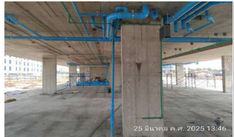
รูปดำเนินการติดตั้งท่อระบบน้ำดี ชั้น 1
