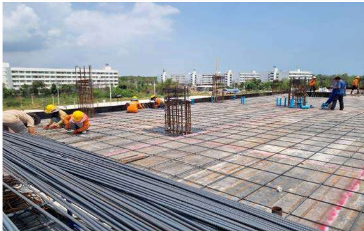
รูปดำเนินการวางเหล็กเสริมพื้นโครงสร้าง ชั้น 4
