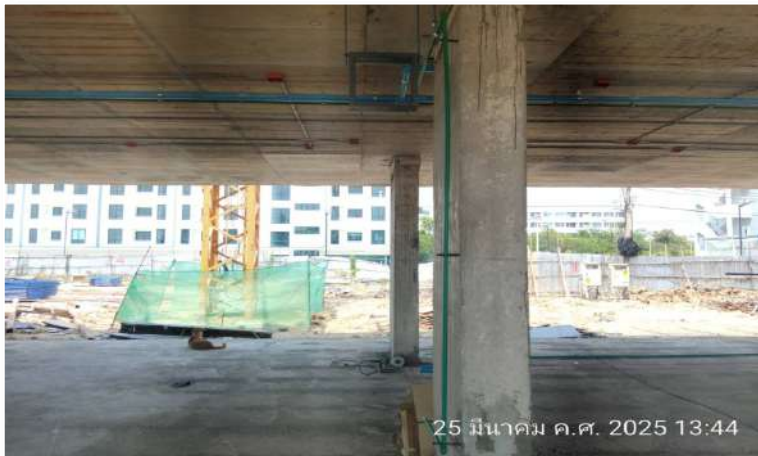
รูปดำเนินการติดตั้งท่อระบบน้ำดี ชั้น 1
